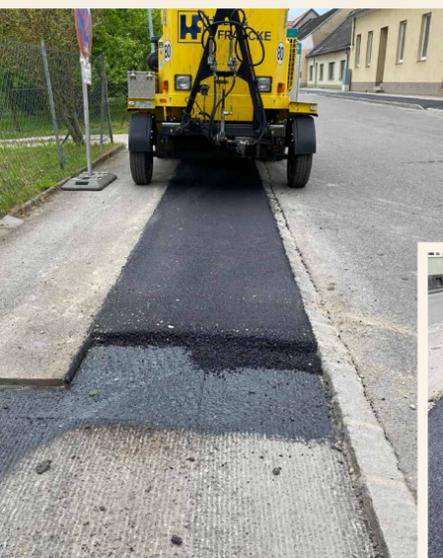
Der „Verschluss“ der Glasfaser-Künetten erfolgte im Vorjahr provisorisch um eventuelle Setzungen abzuwarten. Nunmehr wurden ÖNORM-gerecht die Wiederherstellung der Künetten in der erforderlichen Qualität (Verwendung der richtigen Asphalbkörnung, beidseitiger Asphaltüberhang sowie Verbindung mit Flüssigasphalt samt Dichtungsbändern) durchgeführt.
